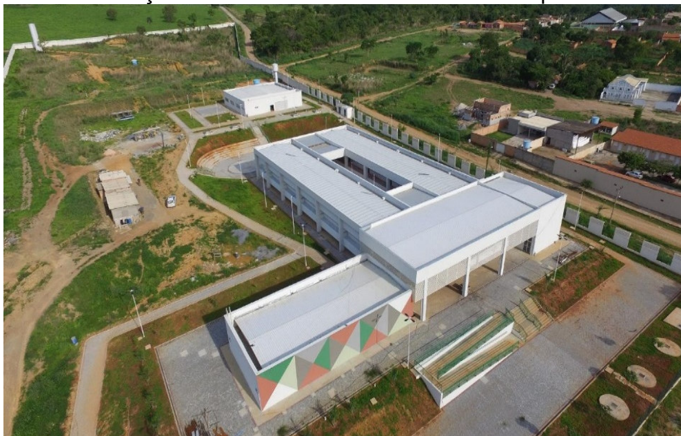
FIGURA 1. Construção do Instituto Federal Goiano em Campos Belos de Goiás.
