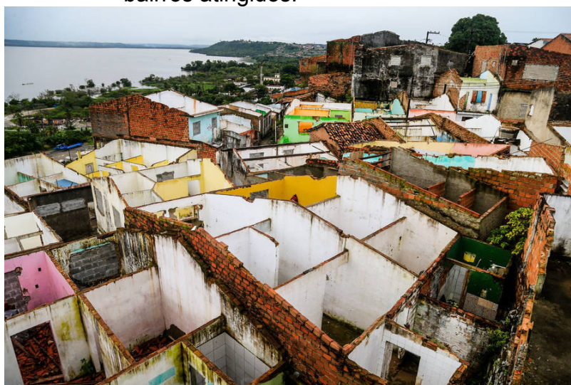
FIGURA 6: Moradias abandonadas na capital Maceió devido a desocupação dos moradores de bairros atingidos.
