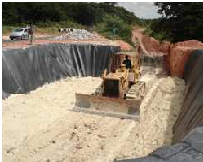
FIGURA 6. Aplicação de fosfogesso no aterro sanitário de Contagem-MG.
