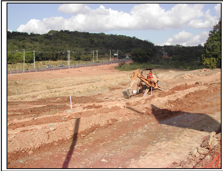
Fotografia I – Obras para construção do Parque tecnológico de Belo Horizonte
