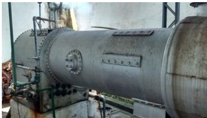
FIGURA 1 – Caldeira Flamotubular horizontal Fonte: Autores (2016)
