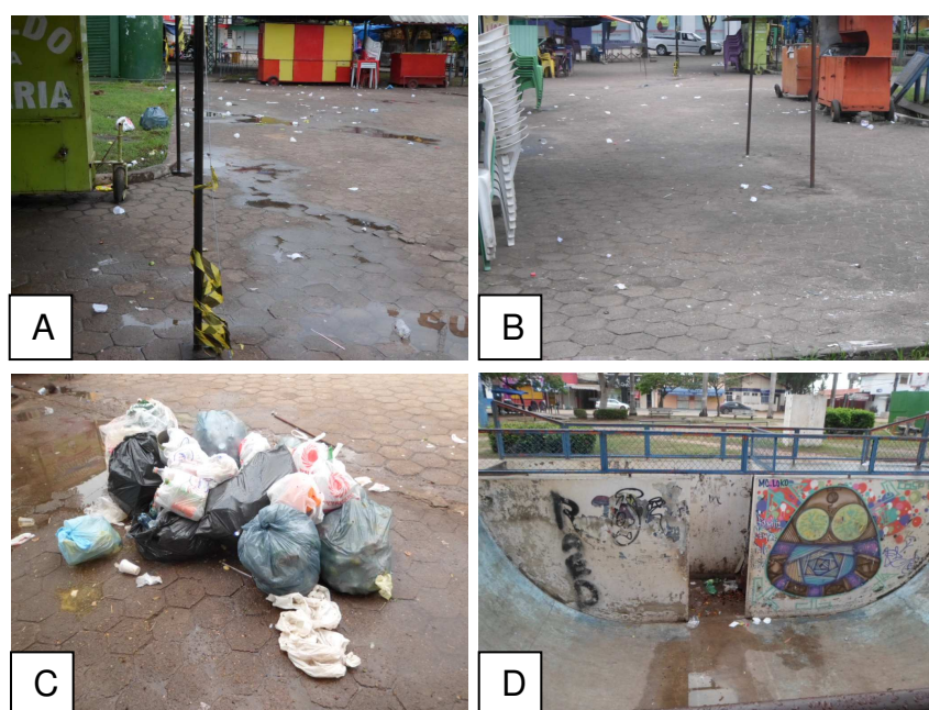
FIGURA 7. A, B, e C - Acúmulo de lixo após a venda de lanches no período noturno. D – Pista de skate com acúmulo de água por ausência de dreno para escoamento. Praça São Francisco, Marabá-PA. Fonte: Autores (2017).
