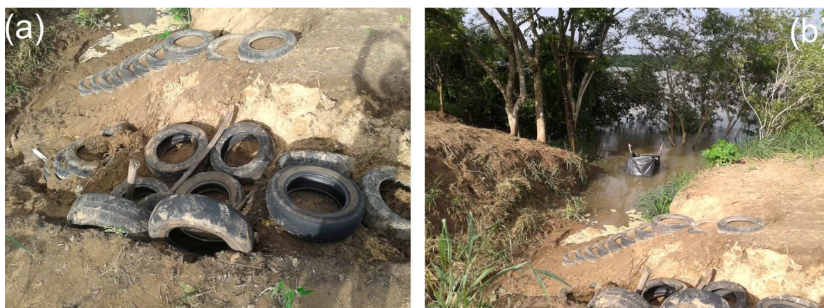
FIGURA 4 – (a e b) Deposição inadequada de pneus na tentativa de conter a erosão e de dar acesso ao rio como escadas (Fonte: autores, 2016).
