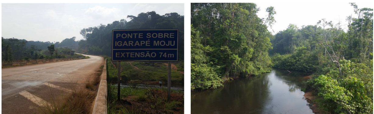
FIGURA 3. Vista da ponte e lado esquerdo do Igarapé Moju na BR-163
