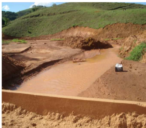
FIGURA 2: Dique que de contenção de sedimentos. Fonte: PRAD da empresa.
