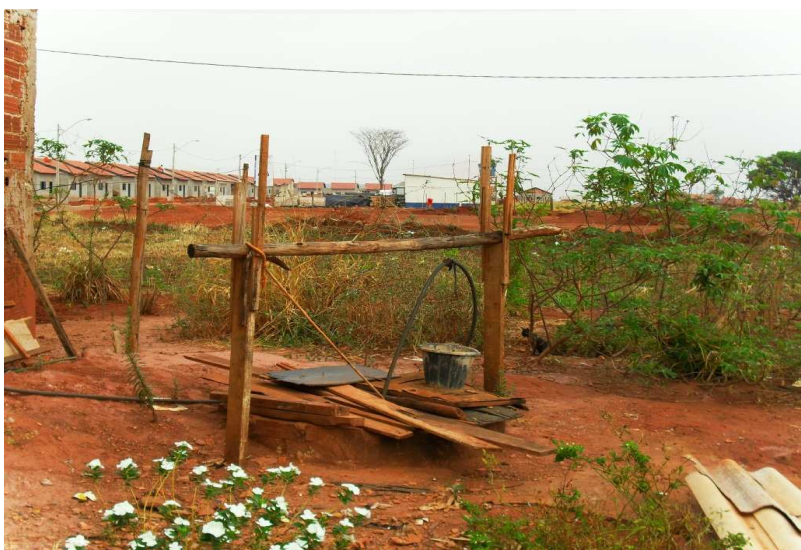
FIGURA 3. Poço raso onde foi feita uma das coletas de amostra de água, sendo a precariedade da estrutura e também a proximidade com a fossa negra, dois dos principais fatores de contaminação da água utilizada pelos moradores
