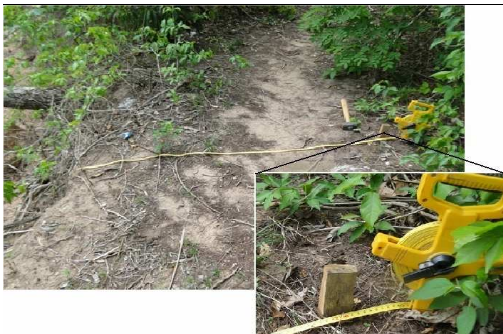
FIGURA 4. Processo de fixação da estaca de madeira.
