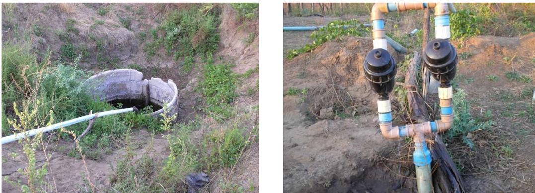
**FIGURA 4.** Poço de captação de água e sistemas de filtragem
