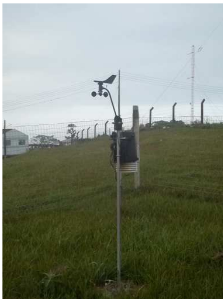
FIGURA 1. Estação automática, localizada no Instituto Federal Catarinense – Campus Rio do Sul, na cidade de Rio do Sul.
