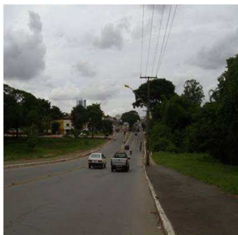
Figura 13 - Ponto 6, divisão do parque por via dupla pavimentada.
