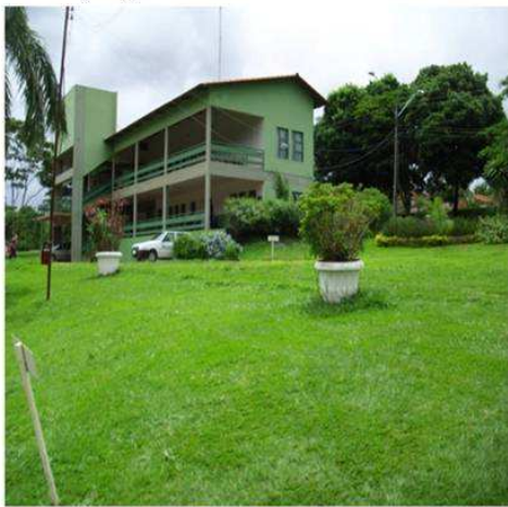
Figura 15 - Ponto 8, impermeabilização e ausência de adensamento vegetal.
