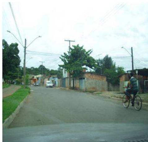
Figura 4 - Ponto 2, habitações irregulares e impermeabilização do solo.
