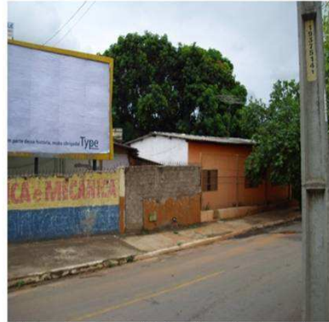
Figura 8 - Ponto 13, habitações irregulares e impermeabilização do solo.
