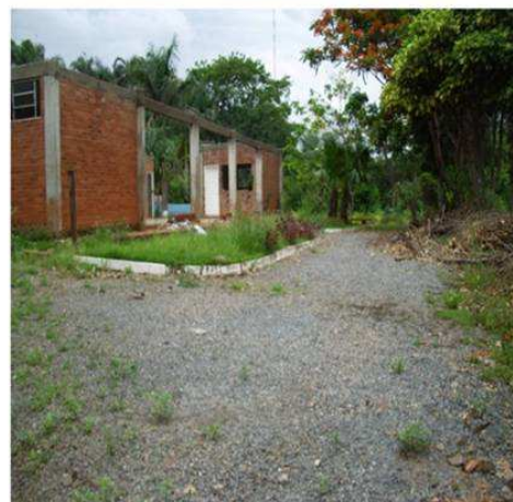
Figura 10 - Ponto 14, desmatamento e restos de construções.
