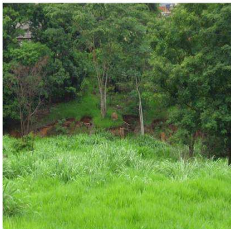
Figura 9 - Ponto 14, desbarrancamento da margem do córrego e erosão.
