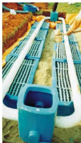
FIGURA 07: Esquema de tratamento de efluentes por valas de infiltração ou septodifusores
