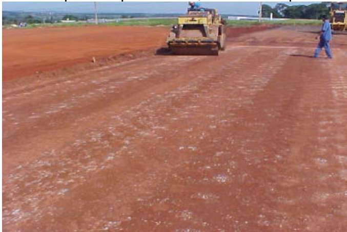
FIGURA 7 – Base executada com agregado reciclado em Goiânia-GO
