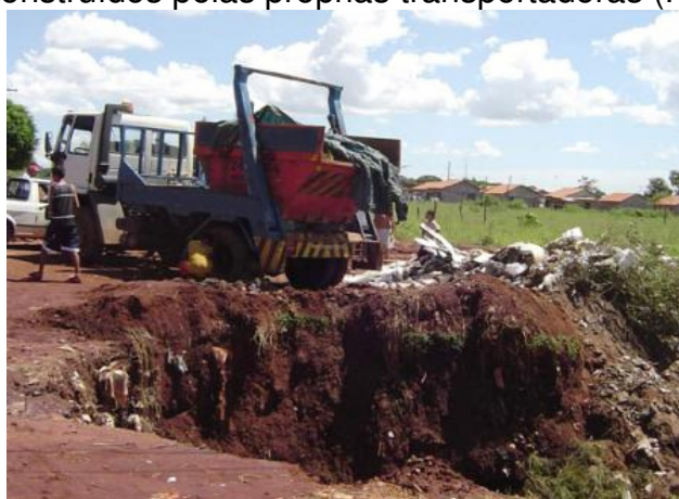
FIGURA 5 – Descarte irregular de resíduos da construção civil – Lote Vago
