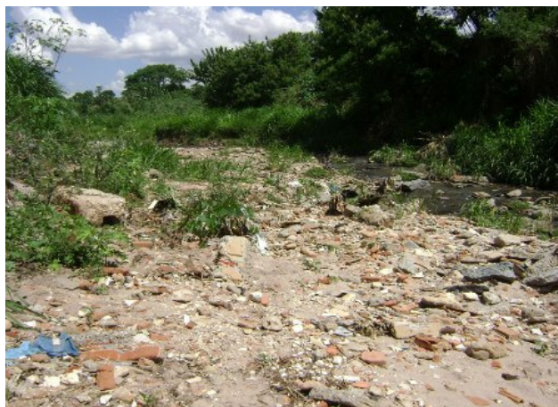
FIGURA 1 - Descarte irregular de resíduos da construção – Córrego Cascavel
