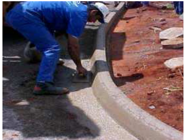
FIGURA 9 – Finalizando a execução do meio-fio Fonte: Silva, 2004.
