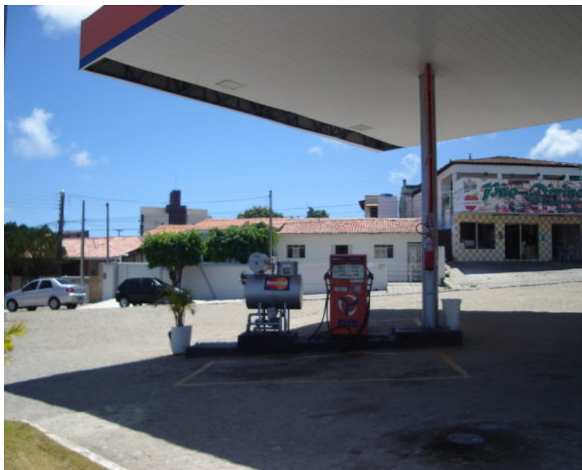
Figura 3 Posto de combustíveis na Avenida Castelo Branco.
