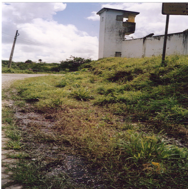
Figuras 13: esgotos oriundos do presídio do Serrotão despejados na rua de acesso ao bairro.
