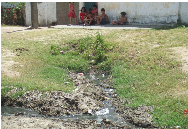
Figura 16: esgotos a céu aberto.
