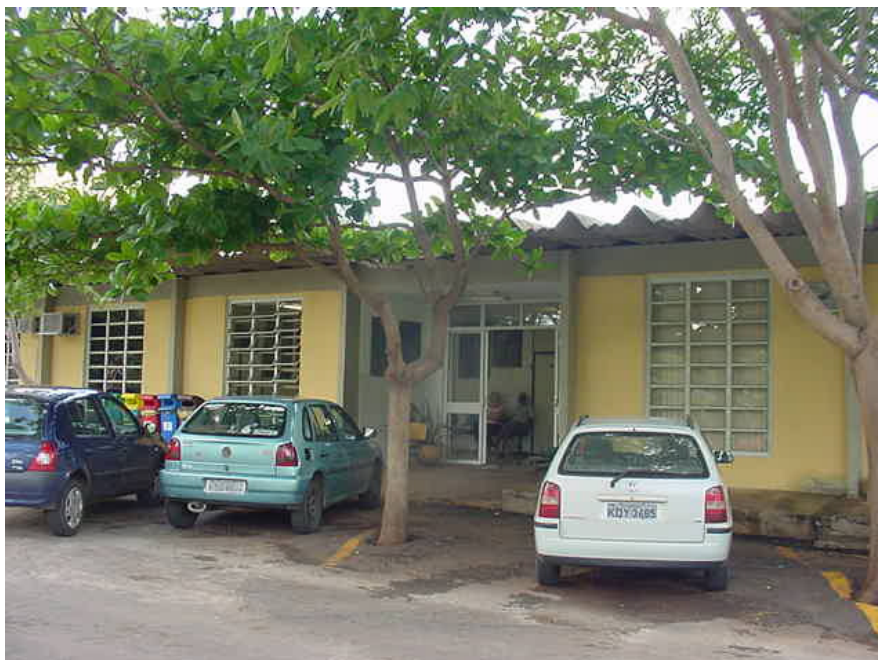
Figura 1- Fachada frontal do prédio do Hospital Veterinário da Universidade Federal de Goiás.
