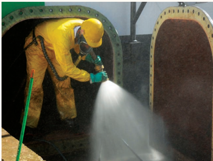
Limpeza na área industrial
